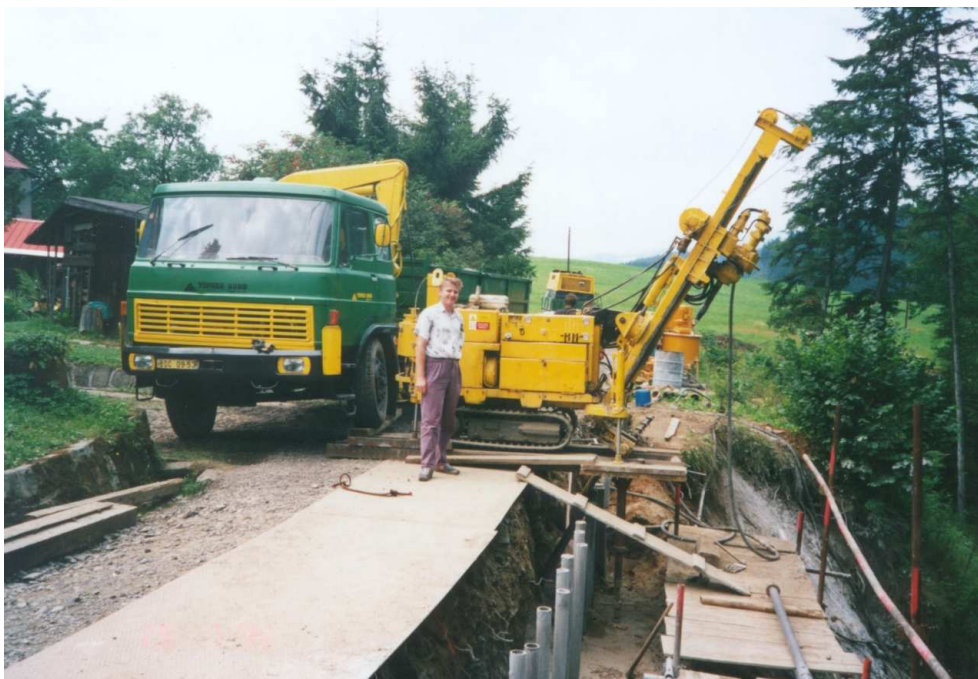
Foto 25 Vrtání kotev
