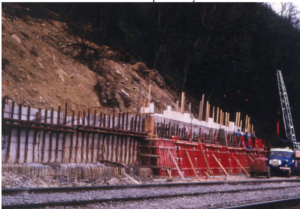
Foto 22 Budování opěrné stěny
