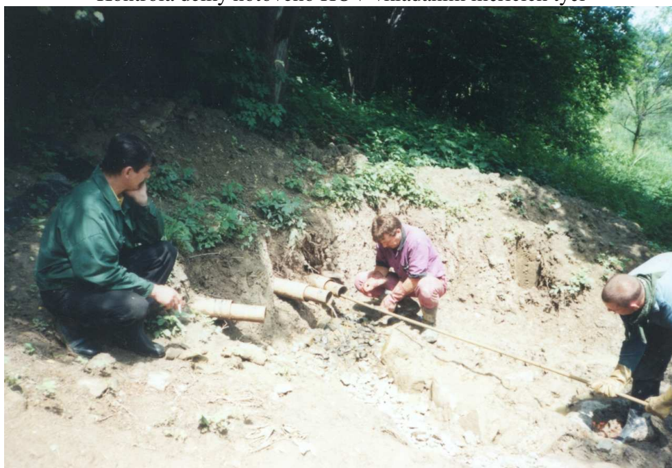
Foto 17 Kontrola délky hotového HOV vkládáním měřících tyčí
