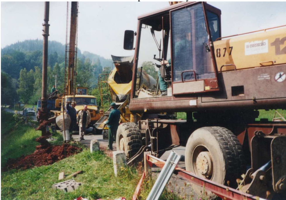
Foto 20 Budování pilotové stěny
