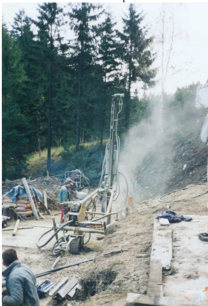
Foto 25 Vrtání kotev
