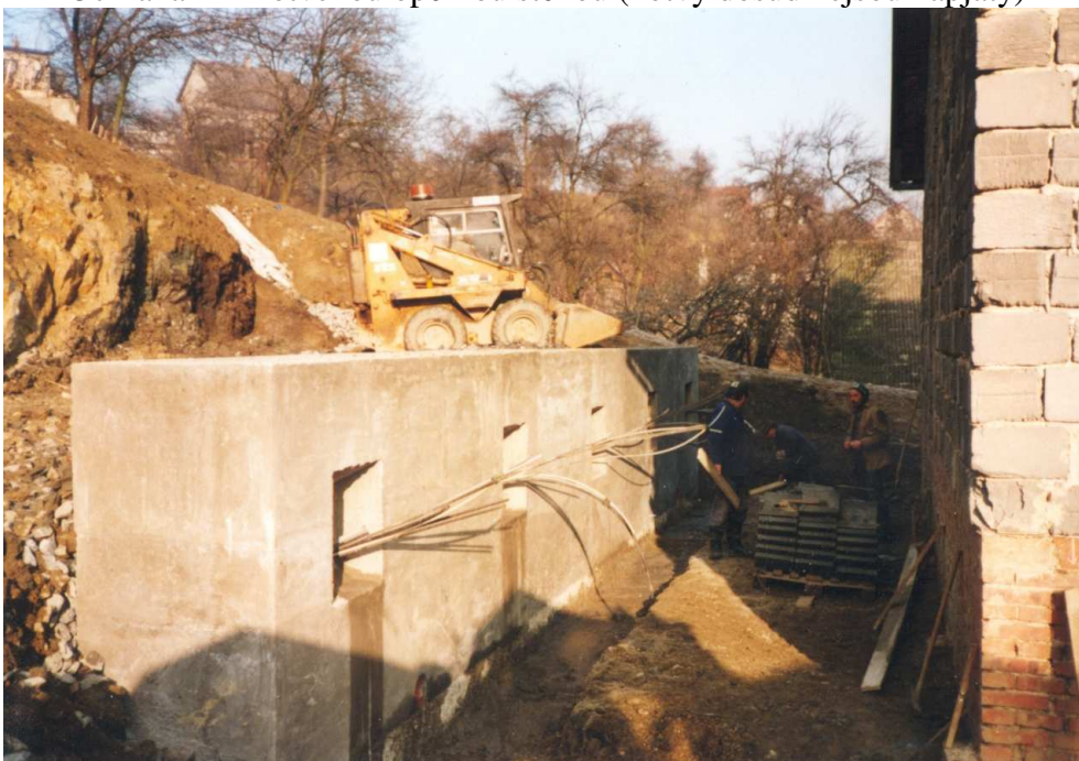
Foto 21 Ochrana RD kotvenou opěrnou stěnou (kotvy dosud nejsou napjaty)
