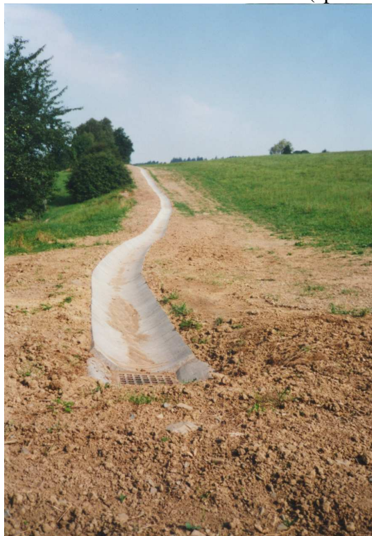
Foto 14 Povrchové odvodnění na sesuvu (zničeno pohybem)
