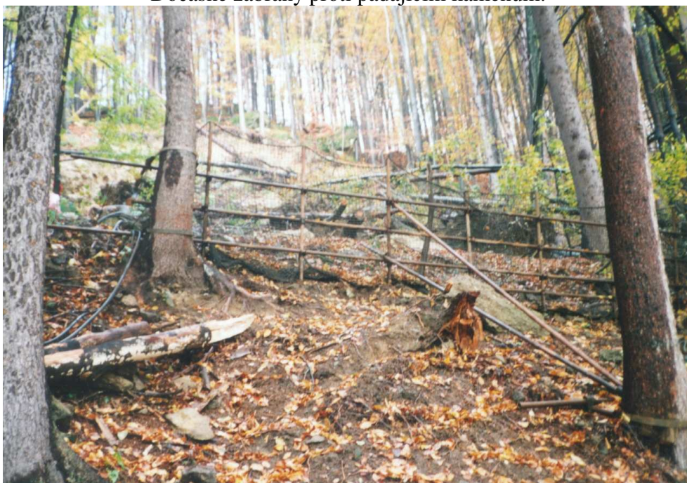
Foto 27 Dočasné zábrany proti padajícím kamenům.
