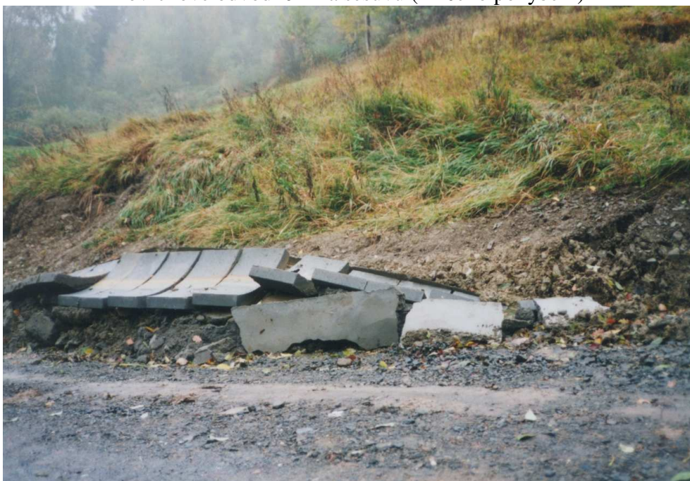
Foto 14 Povrchové odvodnění na sesuvu (zničeno pohybem)
