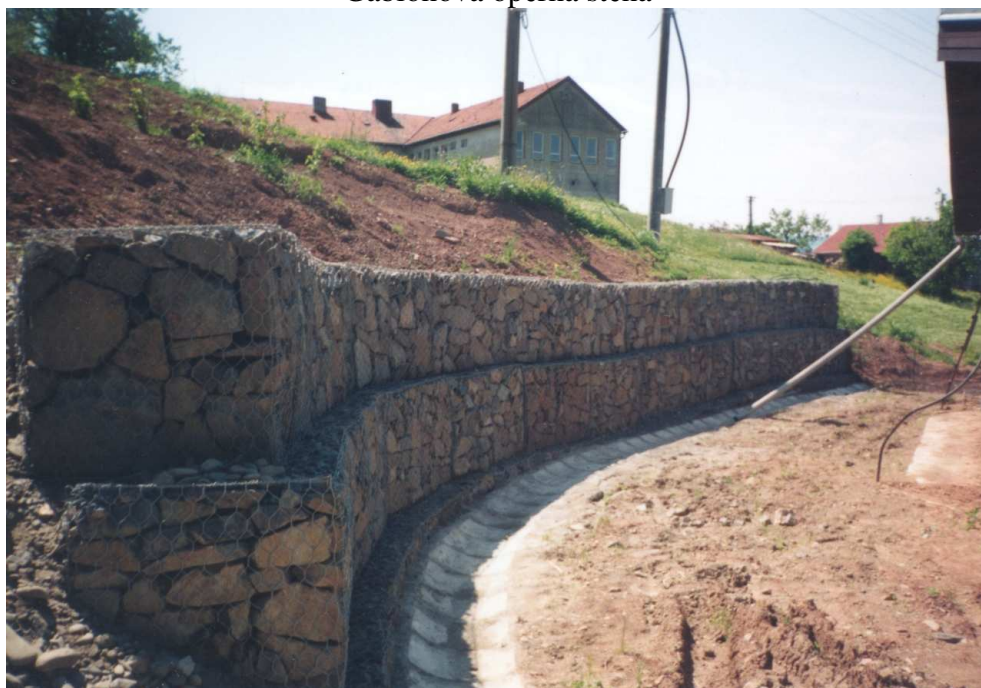
Foto 23 Gabionová opěrná stěna
