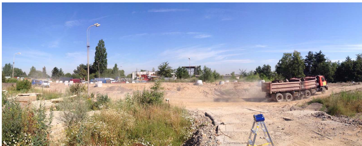
Obr. 2. Pojezd nákladního vozidla po zpevněné komunikaci (prachoměr je umístěn v popředí)
