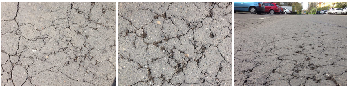
Obr. 6.17.: Silně poškozený povrch
