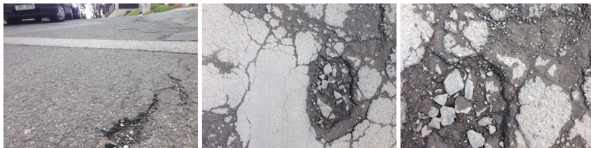
Obr. 6.17.: Silně poškozený povrch
