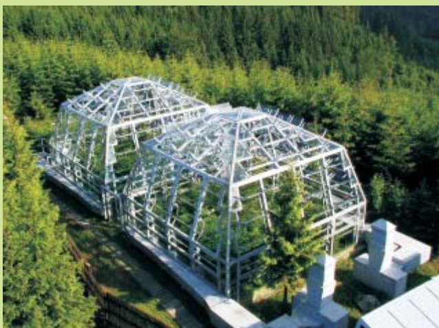
Lamelové kultivační sféry na EEP Bílý Kříž pro pěstování smrkového porostu ve zvýšené koncentraci \text{CO}_2
