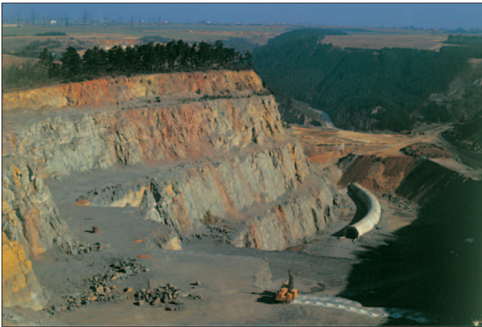
10. Jedním z aktivních lomů na území CHKO Český kras je Hvízdalka u Radotína. Tunel viditelný v pravé části fotografie slouží k odvozu rubaniny z lomu. Halda vytvářená nad tunelem je přizpůsobena původnímu tvaru údolí.
