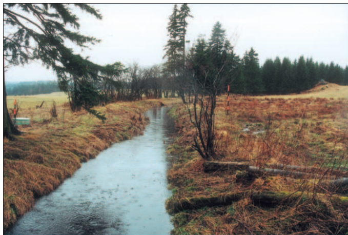
13. Voda se k důlním strojům, vodotěsným zařízením a stoupovněm u Krásna a Horního Slavkova přiváděla pomocí unikátních systémů kanálů zvaných stoky, jejichž celková délka byla až 30 kilometrů. Voda tekla v zahloubených korytech v lesích i po loukách nad údolími zdejších toků. Poblíž obce Prameny najdeme obnovený kanál Dlouhá stoka, který byl na panství Pluhů z Rabštejna vybudován v první polovině 16. století.
