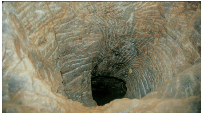
9. Staré důlní dílo Jeroným je pozoruhodnou památkou na dobývání cínových rud. Na stěnách chodeb s povlaky sazí po rozrušování skal ohněm (tzv. sázení ohněm) jsou v žule patrné stopy po nástrojích dávných horníků – želízku a mlátku.
