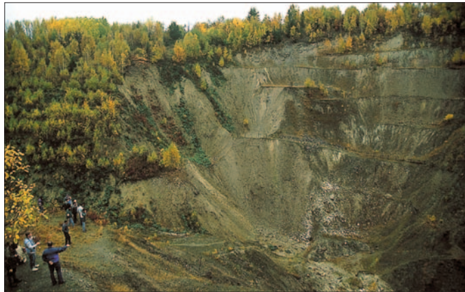
10. Největším povrchovým pozůstatkem po dobývání cínů a wolframu je důlní propadlina na tzv. Habském pni. Mnoho menších důlních děl se tu při velké katastrofě v 17. století v důsledku značného podfárání celého povrchu hromadně propadlo.
