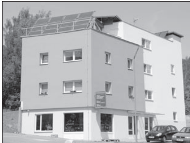
Nízkoenergetický dům v Železném Brodě
