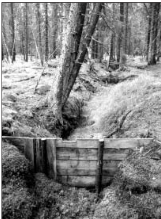
Výstavba dřevěných hrází na Cikánských slatích Foto J. Plamínková
