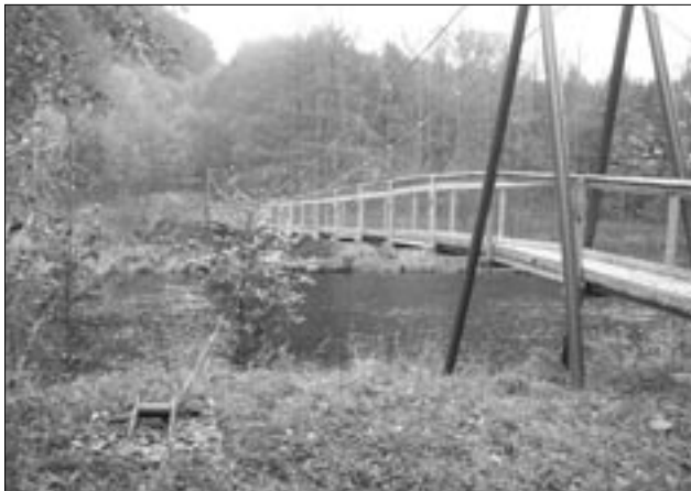
Nová lávka pod Vranovem
