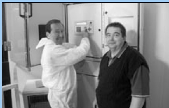
Ministr si prohlíží řídicí jednotku elektrárny v Pavlově
