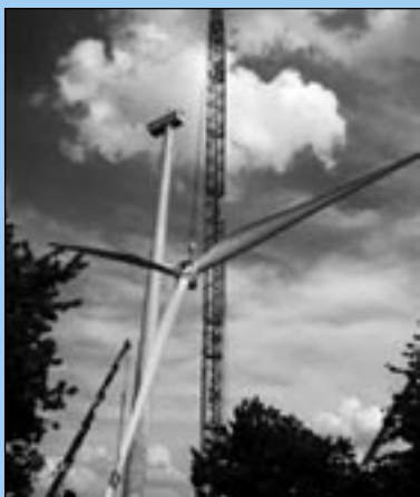
Montáž větrné elektrárny
