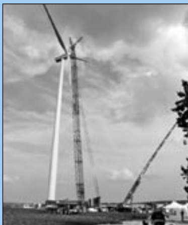
Montáž větrné elektrárny
