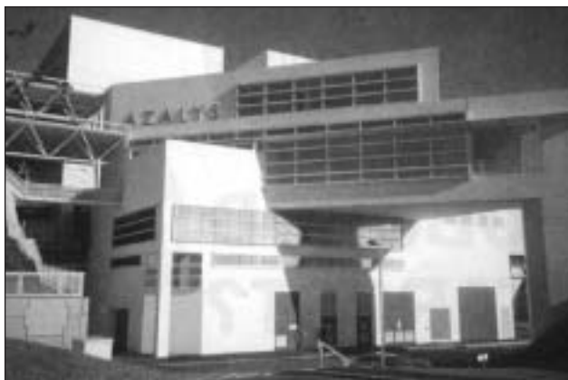
Spalovna Azalys v Carrières-sous-Poissy u Paříže je jednou z nejmodernějších ve Francii. Foto: J. Plamínková
