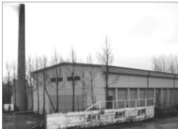
Výtopna v Bystřici
