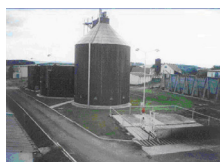
Foto 1: Zemědělská bioplynová stanice Trhový Štěpánov
