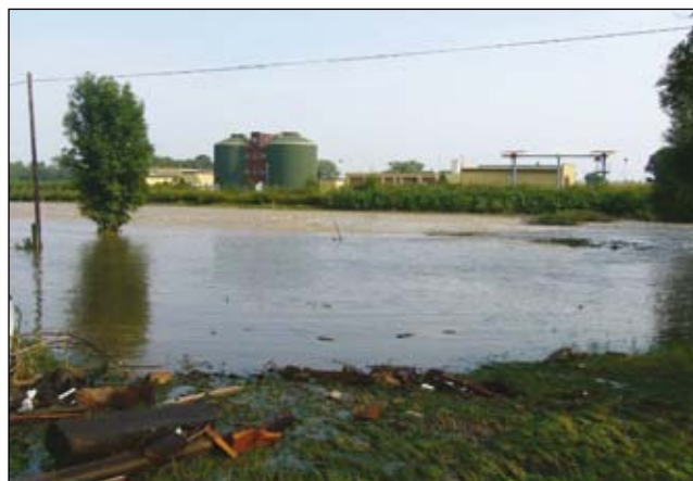
▲ Čistírna odpadních vod v Hrádku nad Nisou byla zasažena povodní.
