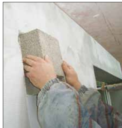
▲ Instalace budek do zateplení panelového domu.
