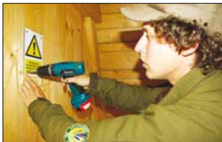
▲ Strážce KRNP Jan Hanuš instaluje upozornění, že přístřešek neochrání před blesky.
