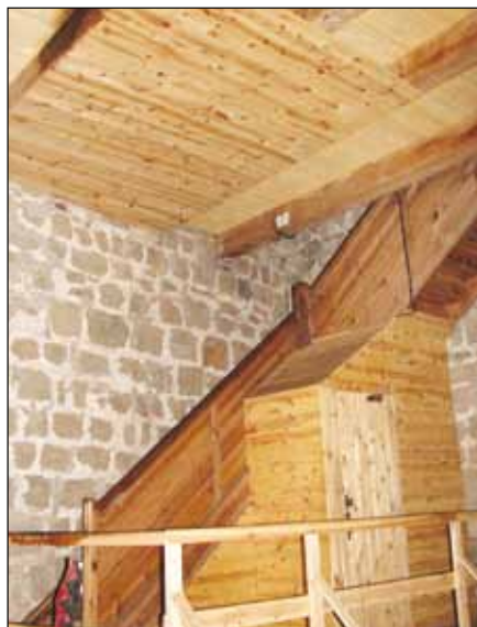
▲ Samozavírací dveře a podbití stropu v prostoru pro návštěvníky věže v Týnci nad Sázavou.
