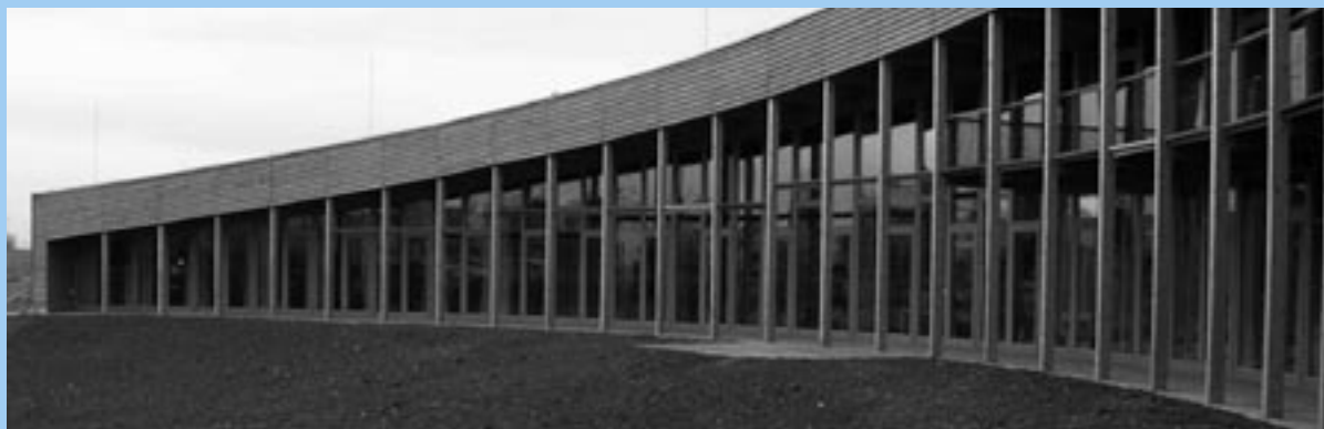
Jižní průčelí budovy je opravdovým estetickým zážitkem
