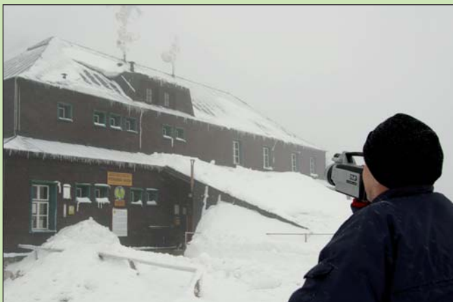
▲ Snímání Rýchorské boudy termokamerou.
