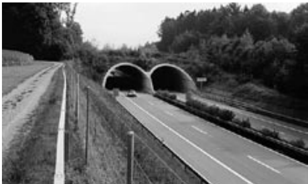
Překonávání dálnic usnadňují volně žijícím živočichům nadzemní přechody. Obrázek ukazuje polopřirodní přechod pro kopytníky na severu Nizozemska.
