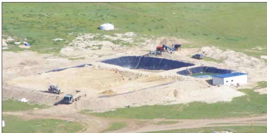
▲ Celkový pohled na zajištěné odkaliště nebezpečného odpadu, lokalita Bortolgoi.
