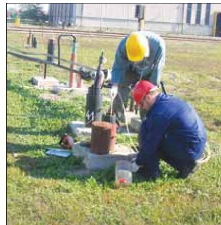
▲ Seřizování sanačního systému pro odčerpávání.
