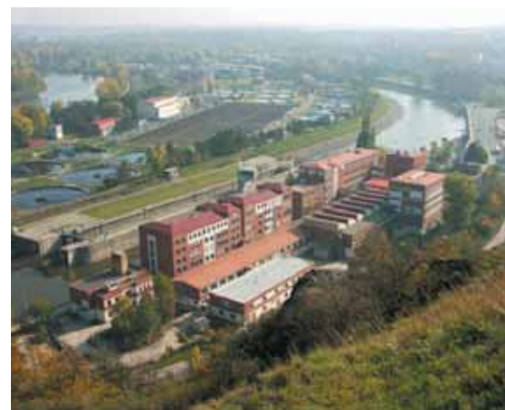
Celkový pohled na současnou podobu areálu VÚV T.G.M. v Praze-Podbabě.
