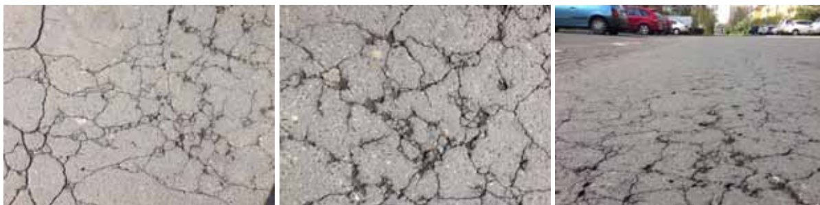
Obr. 6.17.: Silně poškozený povrch
