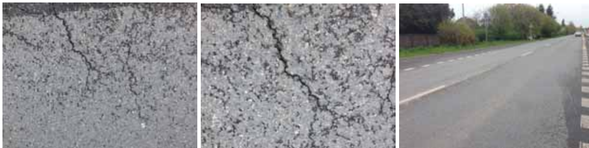
Obr. 6.16.: Poškozený povrch
