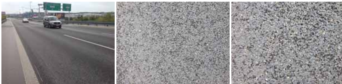
Obr. 6.8.: Asfaltový koberec mastixový
