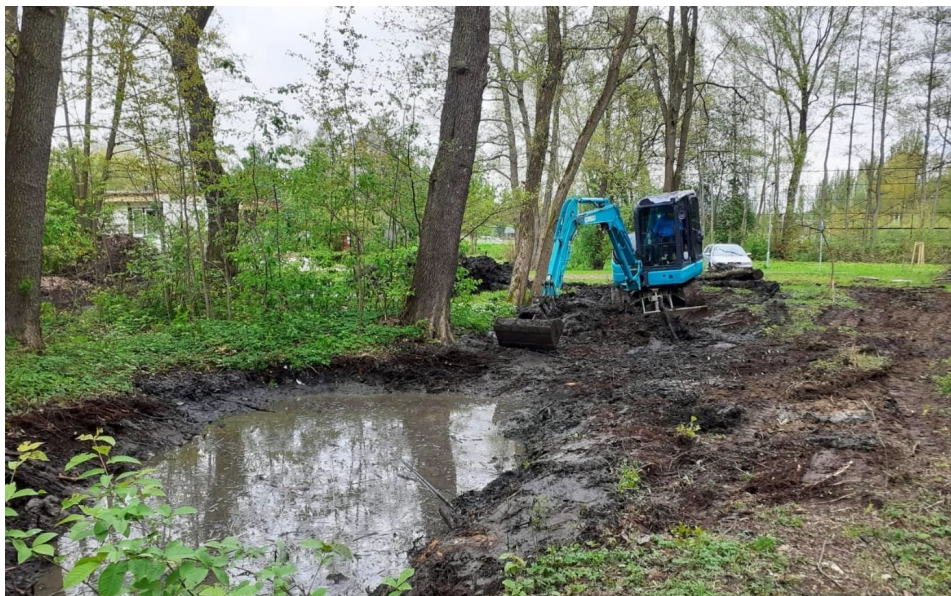
Bagrování tůň u Nového Boru
